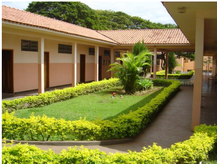
Figura 53 – Foto – APAE Raio de Sol
